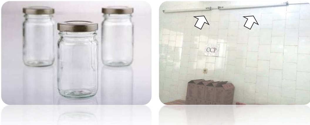
Gambar 5. Kemasan botol baru (kaca, ukuran 150 gram) & Pemasangan UV untuk sterilisasi ruang
