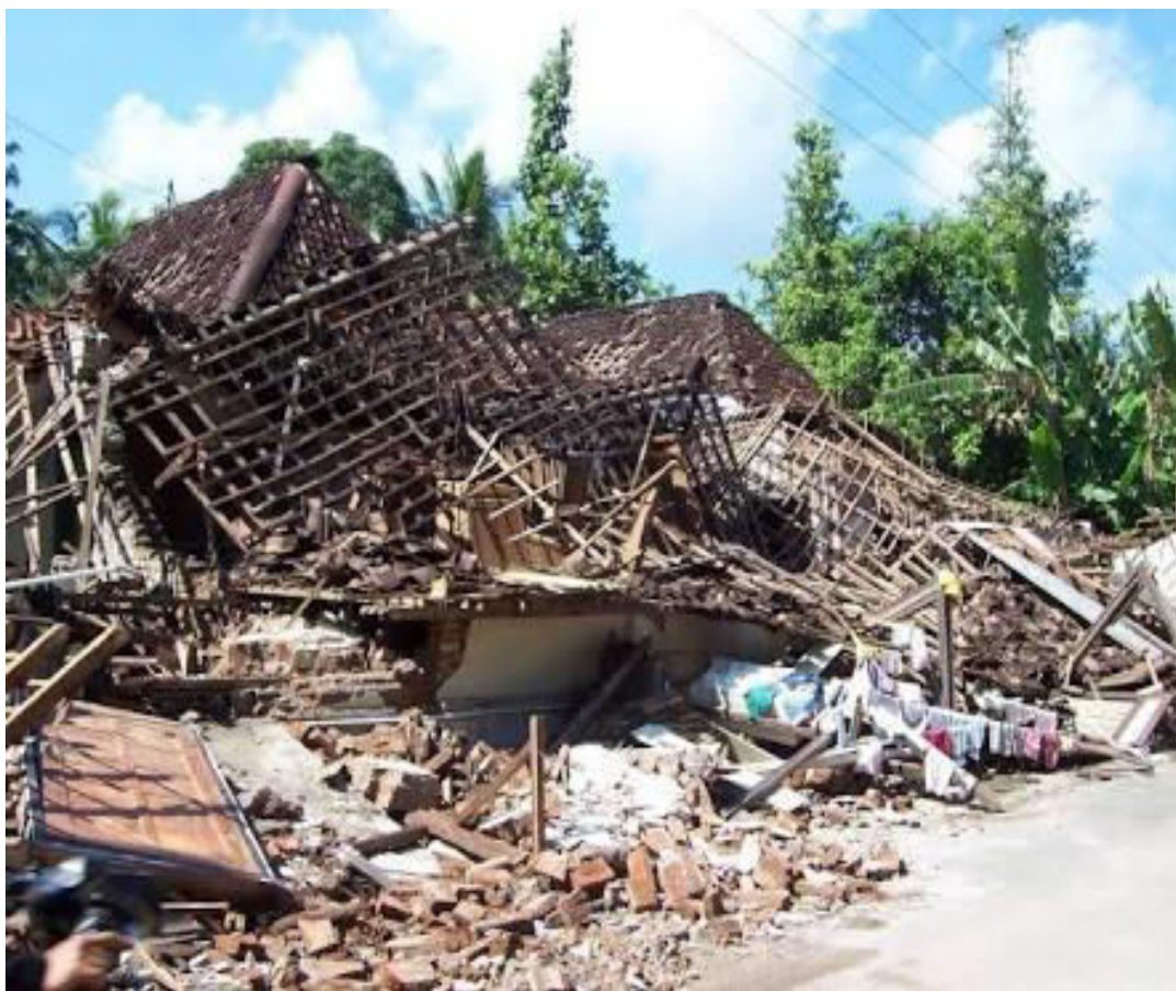
Gambar 27. Gempa yang Terjadi di Daerah Berisiko Padat Penduduk dan Bangunan Tidak Tahan Gempa (sumber : 27mei.blogspot.com)
