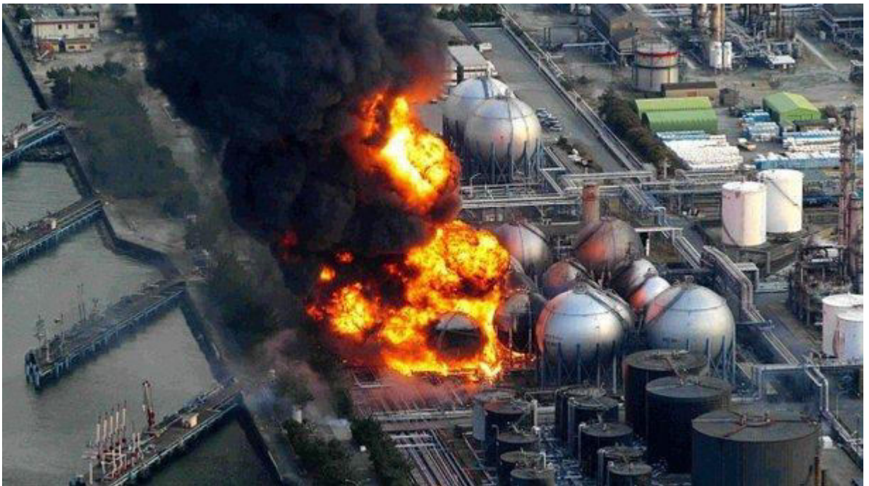
Gambar 29. Kerusakan Bangunan Industri Kimia Dampak Gempa Bumi (Sumber : telegraph.co.uk)
