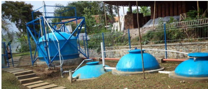
Gambar 8. Digester model Fixed Dome , untuk pengolahan limbah pabrik tahu di desa Kalikajing, Kabupaten Banyumas pada tahun 2013.
