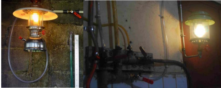
Gambar 14. Pemanfaatan biogas sebagai bahan bakar lampu petromaks, di Desa Nongkojajar, Kabupaten Malang.
