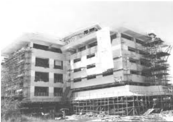
Proses Pembangunan Gedung Perpustakaan Ubaya Tenggilis berlangsung sejak 1 Oktober 1993 sampai dengan 1 November 1995.
