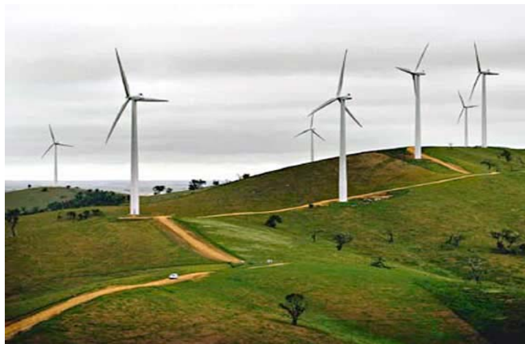
Gambar 5.1. Turbin angin terpasang pada suatu daerah (sumber: http://windturbinezone.com/wind-technology/wind-farms )
