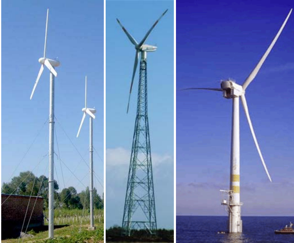
Gambar 5.7 : Berbagai tipe tower sistem pembangkit listrik tenaga angin: Guyed (kiri) Lattice (tengah) Mono-structure (kanan)
