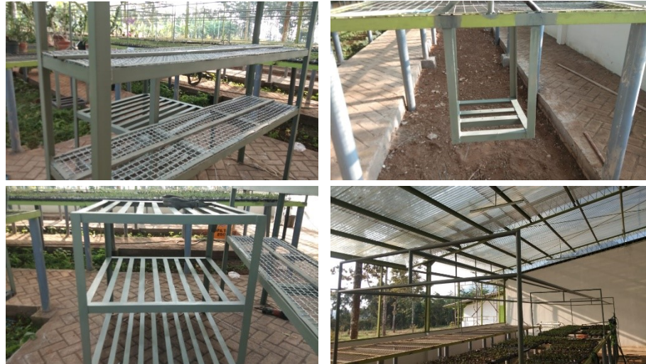
Gambar 12. Penambahan asesoris rak meja tanam dalam rangka penguatan struktur dan mendukung otomatisasi greenhouse PPAU.
