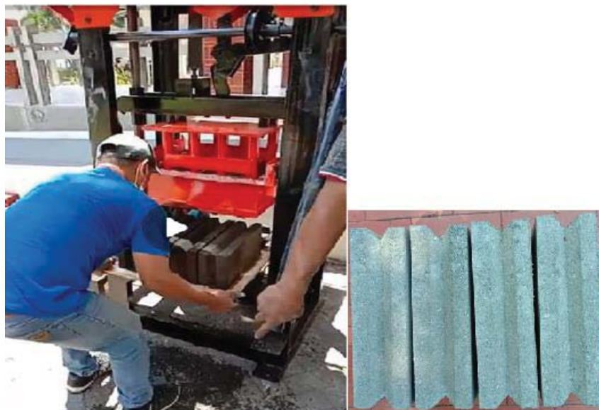
Gambar 3. Pengujian Performansi Mesin Cetak Batako dan Hasilnya
