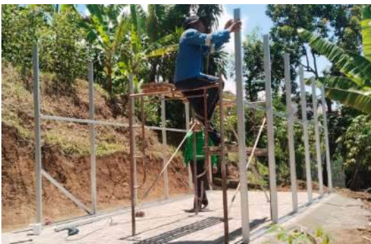
Gambar 7. Rangkaian struktur rumah pengering material galvanis anti karat
